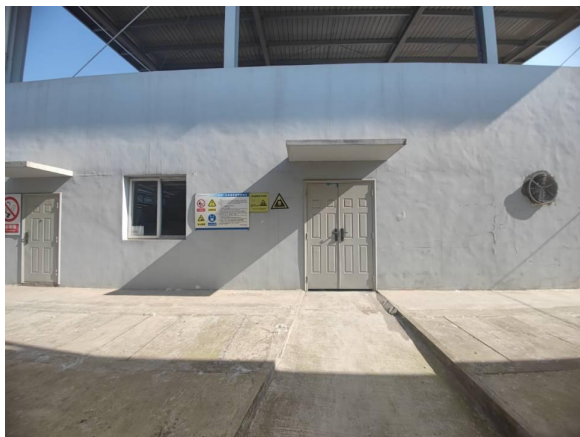
危险废物暂存间外设置标识
