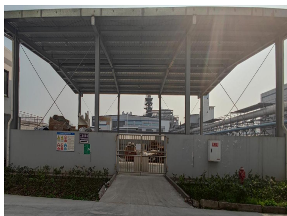
一般固体废物暂存场设置情况
