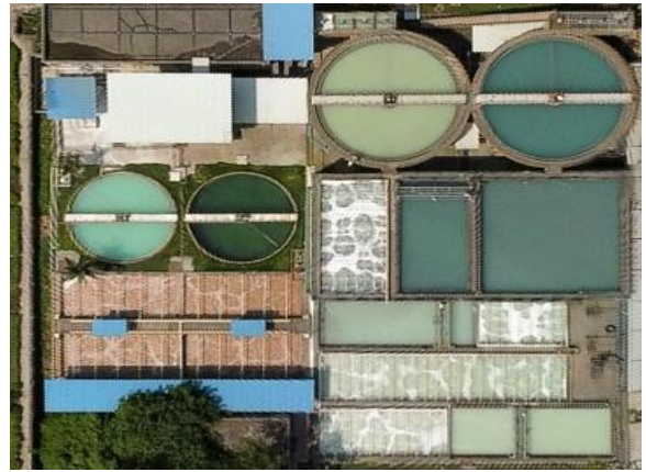
厂区污水处理站（依托）
