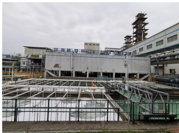
厂区污水处理站（依托）
