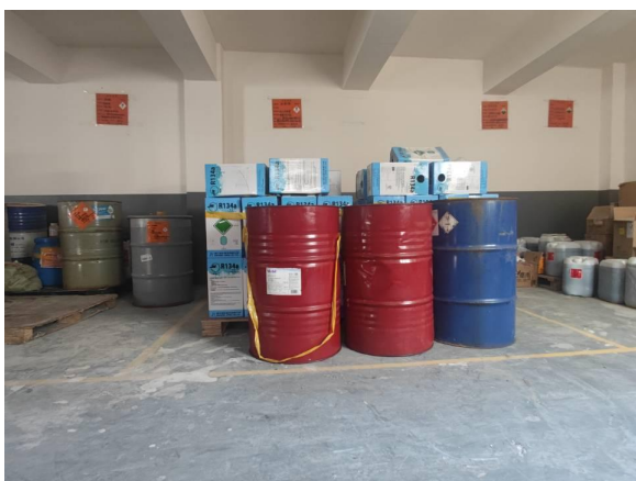
危险废物暂存间地面防渗防腐
