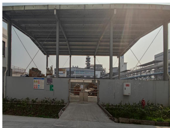
一般固体废物暂存场设置情况
