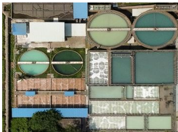
厂区污水处理站（依托）
