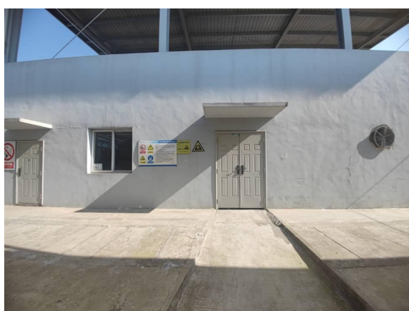
危险废物暂存间外设置标识
