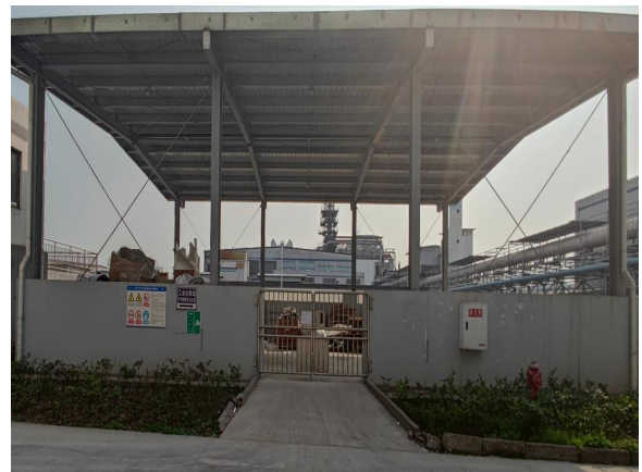
一般固体废物暂存场设置情况
