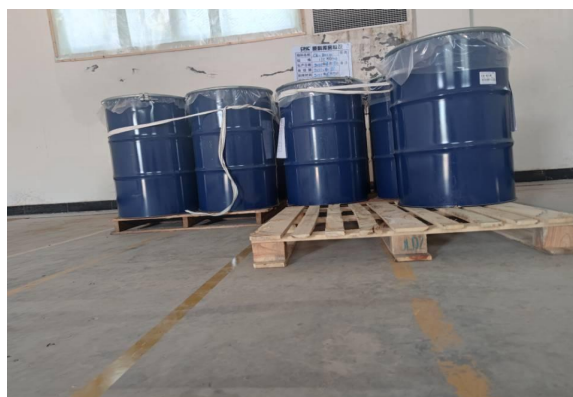
危化品库地面采取防渗措施
