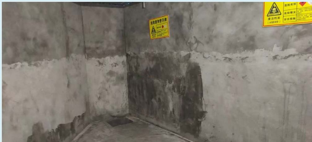
危废间地面、墙角、导流沟、收集池防渗处理现场图
