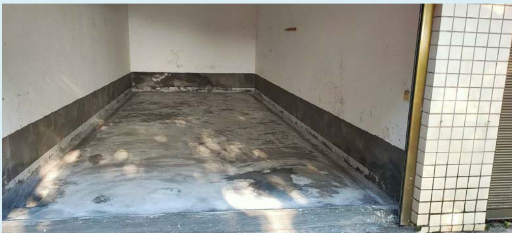
药剂库房地面、墙角、导流沟、收集池防渗处理现场图
