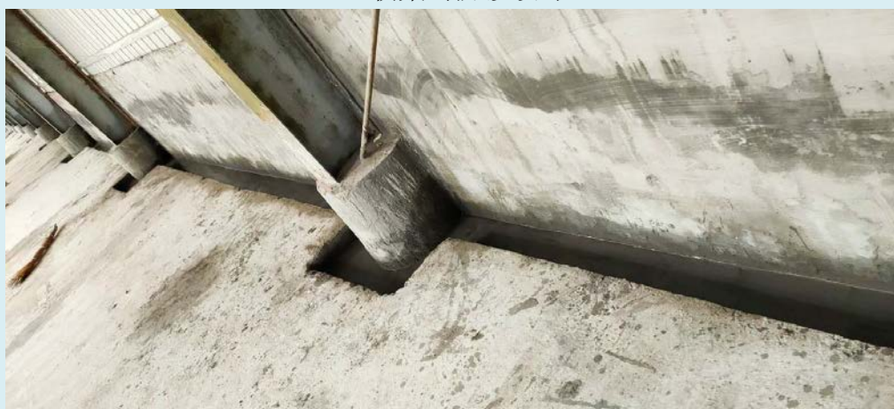
废水收集沟防渗处理现场图
