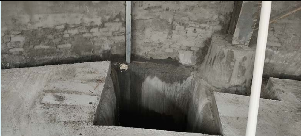
废水收集池防渗处理现场图
